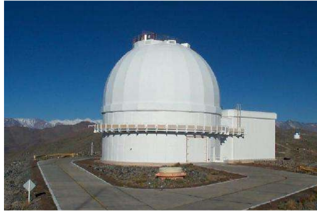
Du Pont 2.5m
